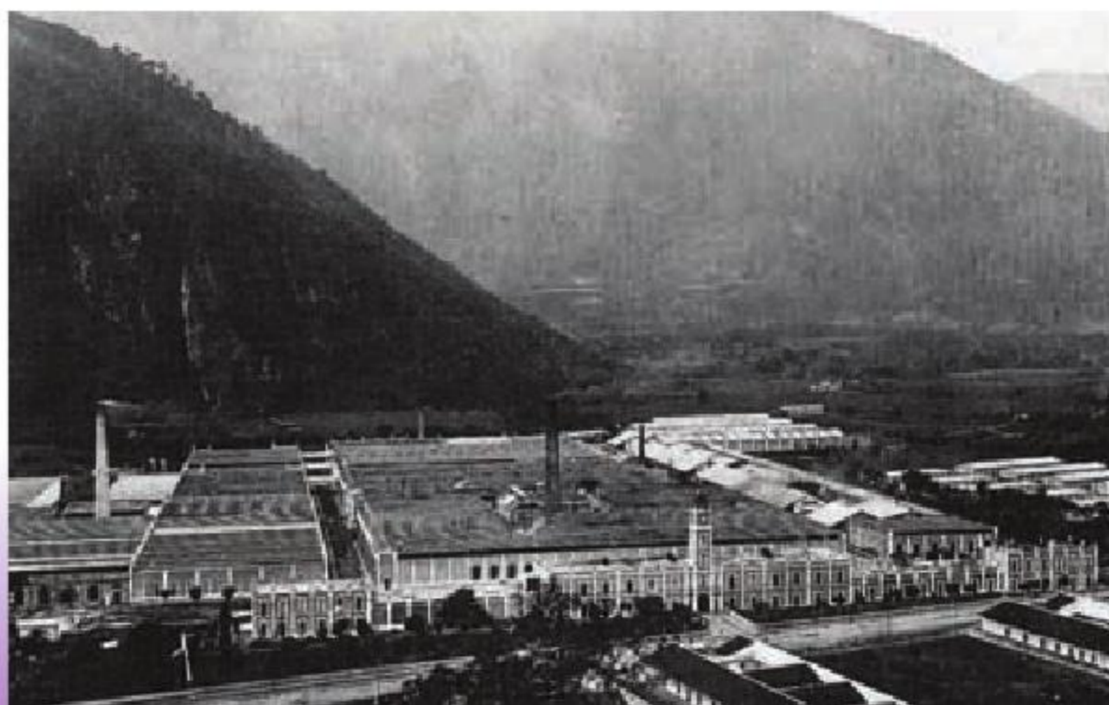
Panorámica de la fábrica Santa Rosa, en Río Blanco (ca. 1906).
